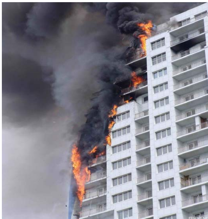
Рис. 1. Распространение пожара по фасаду
